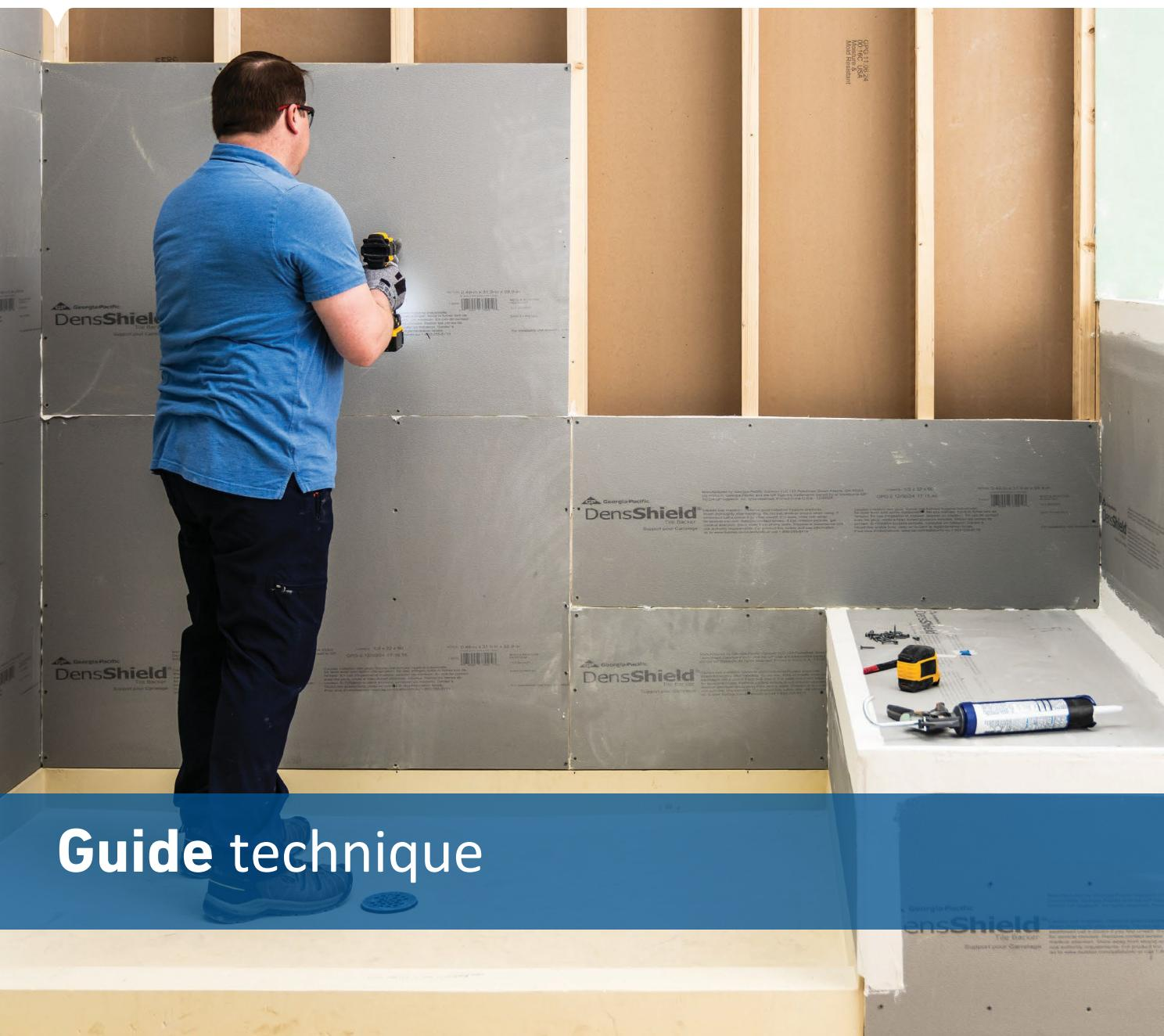
Grâce à sa barrière intégrée contre l’humidité, le support de carrelage DensShield® offre aux entrepreneurs, poseurs de carreaux et bricoleurs une solution plus intelligente et plus efficace. Que vous travailliez sur des murs, des plafonds, des planchers ou des comptoirs, le support de carrelage DensShield® offre une fiabilité et des performances éprouvées.
