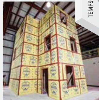
Essai 3 : Système de barrière DensElement MD
