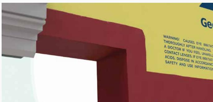
1. Apprêtez les bordures de gypse exposées du revêtement extérieur DensElement™ avec un apprêt R-Guard® PorousPrep™ à base d'eau.
